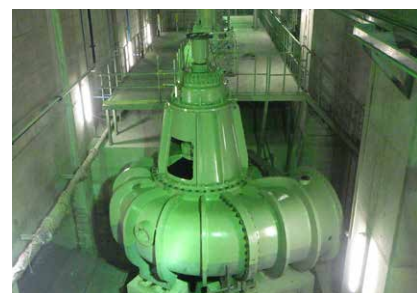
●新千田ポンプ場(広島市中区) 大型ポンプを地下約30mに増設する難易度の高い施工を、優れた技術力で実現した
